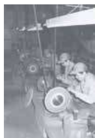
当時の作業現場
